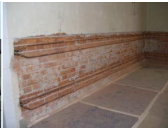
Kirche Vaterstetten: Minimaltemperierung in einer Kirche Ziel: Klimastabilisierung und Minimalbeheizung
