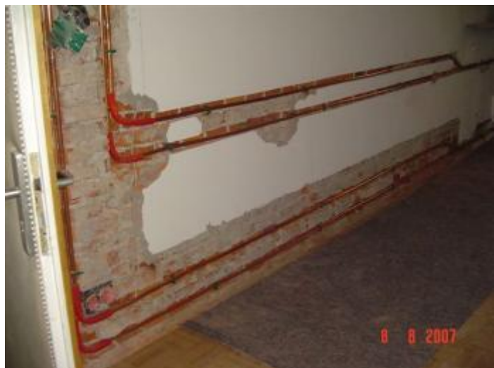
Josephsplatz München: Vorzustand eines Kellers mit Feuchteschäden und Installation eines Temperiersystems im betroffenen Keller.
