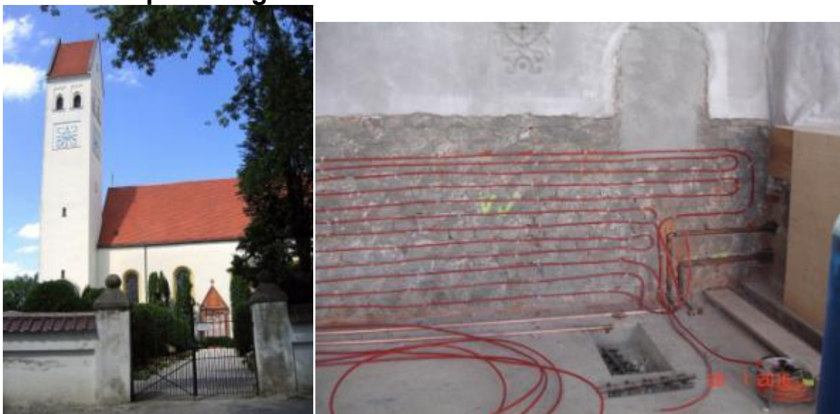
Kirche St. Lorenz Oberföhring; Kirchentemperierung mit niedrigen Rücklauftemperaturen und Beheizung sowie Klimastabilisierung; Bankheizung als Zusatzheizung.
