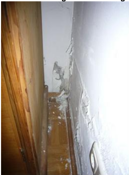
Josephsplatz München: Vorzustand eines Kellers mit Feuchteschäden und Installation eines Temperiersystems im betroffenen Keller.
