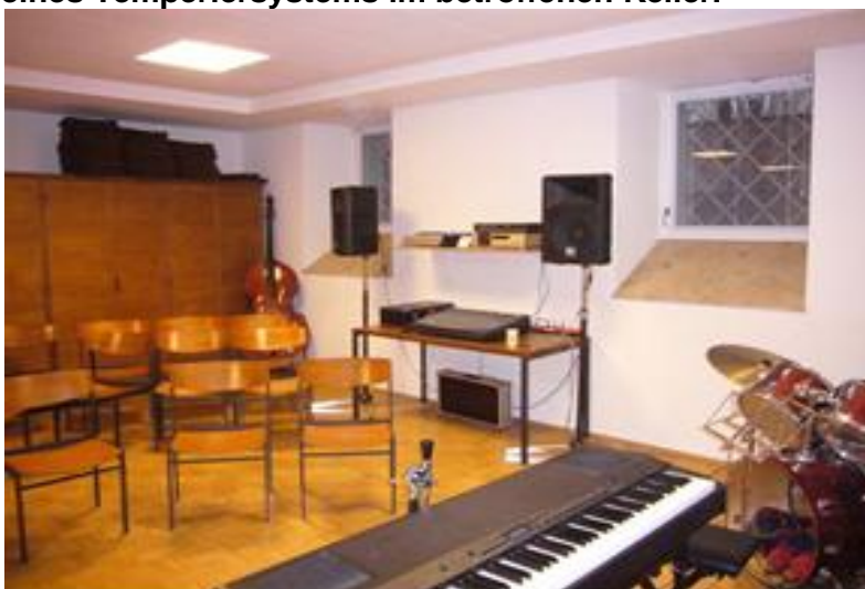
Josephsplatz München: Nutzbarer Kellerraum nach Installation einer Temperierung
