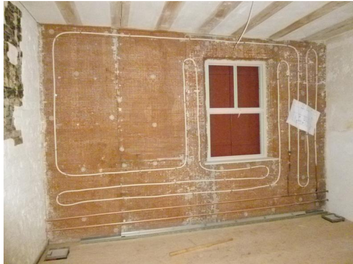
Wohnhaus Nürnberg: Temperierung zur Beheizung und Bauwerkschutz
