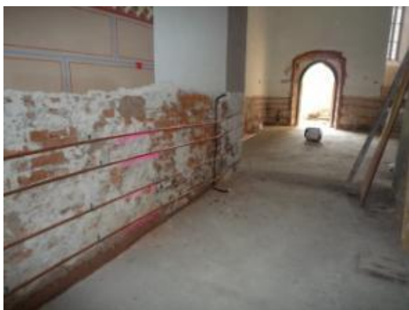
Basilika Münchaurach: Temperierung mit Wand- und Bodentemperierung
