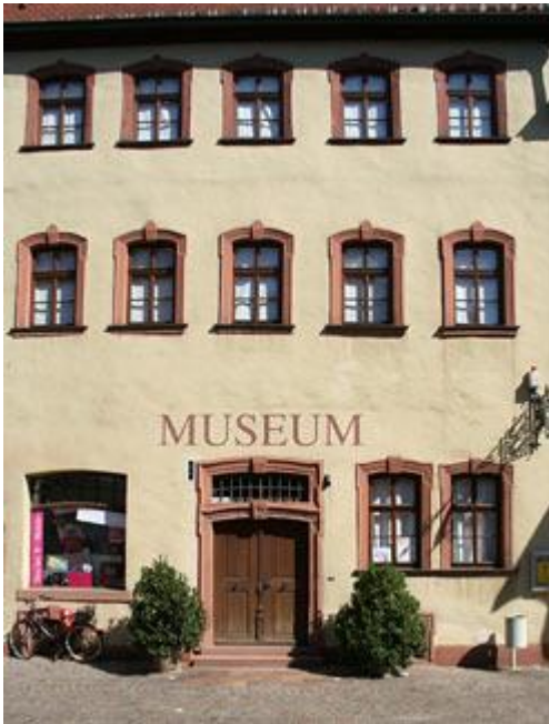
Aktuelles Projekt 2018/2019 Museum Karlstadt am Main: Temperierung zur Klimastabilisierung und Bauwerkschutz sowie Teilbeheizung
