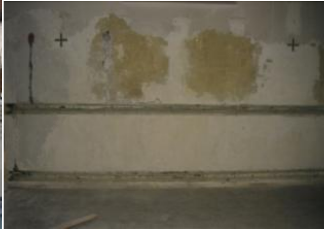
Kirche Oberau: Minimaltemperierung in einer Kirche Ziel: Klimastabilisierung und Minimalbeheizung
