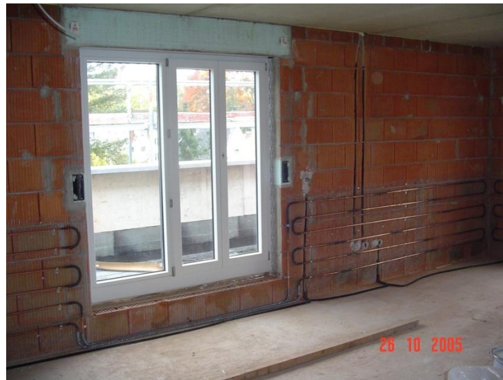
MFH Erlangen: Temperierung zur Gebäudebeheizung im Neubau Ziel: Behaglichkeitssteigerung und Kosten
